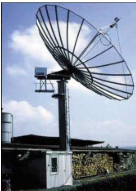
Die 6 t schwere Konstruktion des 10-m-Spiegels
